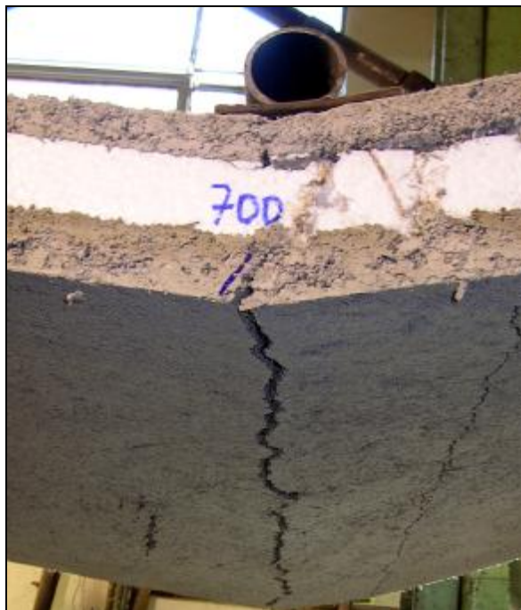
Foto 4. Detalle de la falla por tracción del hormigón de la cara inferior del panel. (en la Foto panel N°1)
