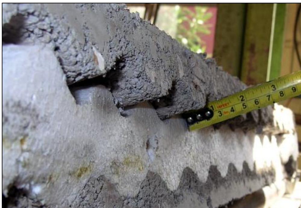
Foto 5. Detalle del deslizamiento del hormigón de la cara superior del panel al producirse la falla. (en la Foto panel N°1)
