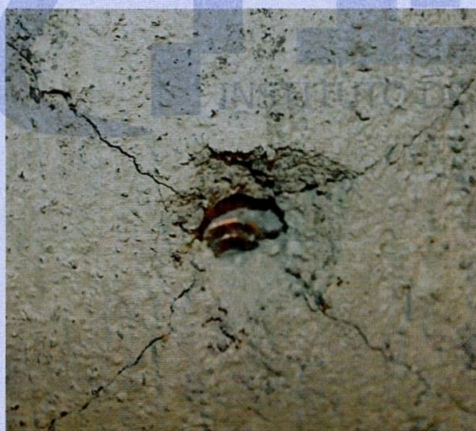
Vista frontal del panel de concreto, disparado con 9x19mm nivel II NIJ 0108.01. Luego del ensayo Vista frontal
