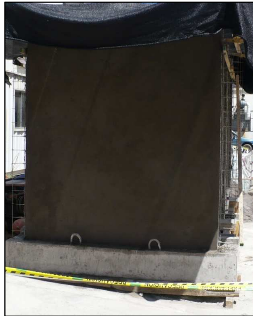
Fotos 6 y 7. Proceso constructivo. Aplicación de capas de mortero sobre el panel.
