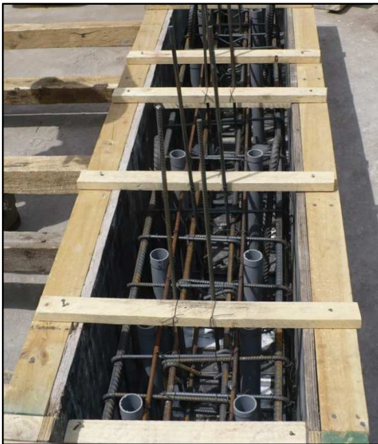
Fotos 4 y 5. Proceso constructivo. Disposición de armadura de refuerzo y moldaje en viga de fundación y anclaje de la estructura interna del panel a la fundación, respectivamente.
