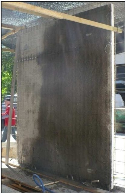
Fotos 6 y 7. Proceso constructivo. Aplicación de capas de mortero sobre el panel.
